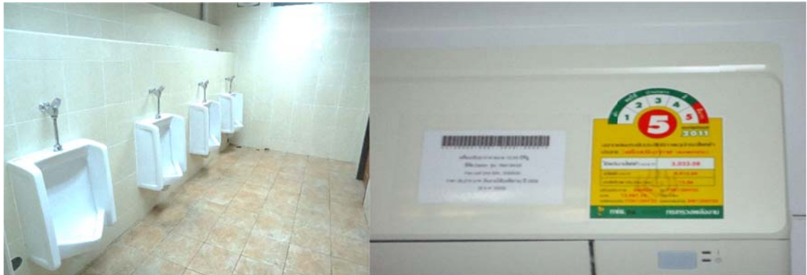
ภาพที่ 3 สุขภัณฑ์แบบประหยัดน้ำและเครื่องปรับอากาศประหยัดไฟเบอร์ 5
