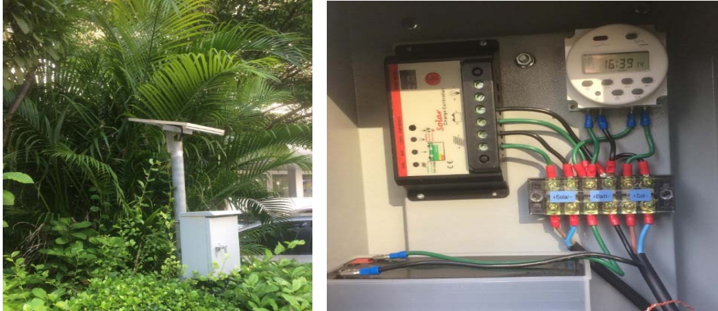
ภาพที่ 3 กิจกรรมการติดตั้งระบบรดน้ำต้นไม้อัตโนมัติโดยใช้พลังงานแสงอาทิตย์
