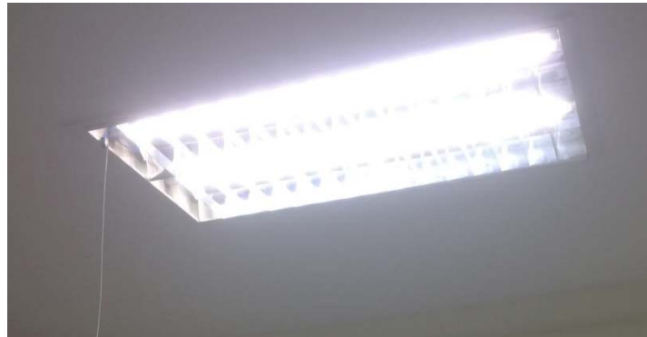
ภาพที่ 1 กิจกรรมการติดตั้งสวิตช์กระตุกสำหรับการลดพลังงานไฟฟ้า-แสงสว่าง
