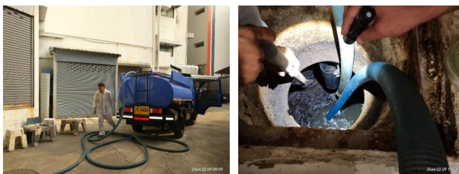
ภาพที่ 20 - 21 : การซ่อมบำรุงและล้างบ่อบำบัดน้ำเสีย อาคาร 44
